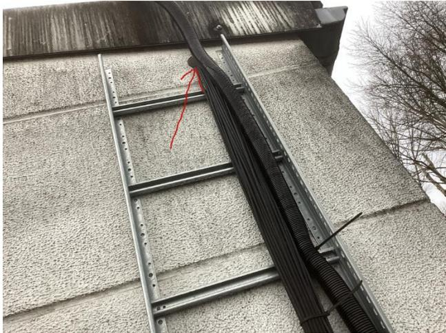
Abbildung 3: fehlende Kabelbefestigung und zu hohe mechanische Belastung
