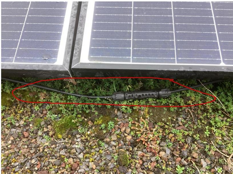
Abbildung 2: Steckverbinder liegt in der wasserführenden Schicht
