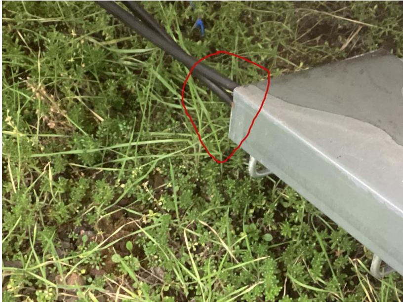
Abbildung 1: fehlender Kantenschutz
